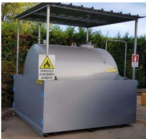
Figura 98 – Esempio di skid per stoccaggio e rifornimento gasolio e di container per stoccaggio sostanze pericolose
